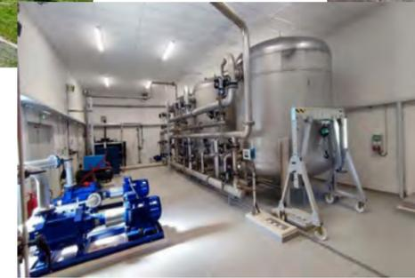
Capacité maximale : 2800 m<sup>3</sup>/jour et 140 m<sup>3</sup>/h, alimentation par 5 forages. Distribution pour 6000 habitants. Traitement au charbon actif de houille.
